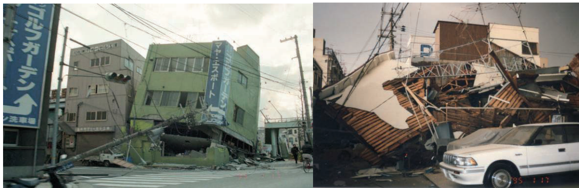
写真1 コンクリート造
